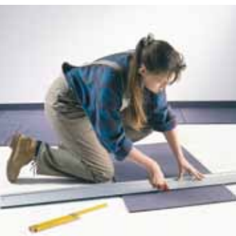
GUTEX Happy Step se coloca de forma flotante y a mata juntas.
