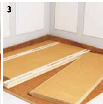
GUTEX Thermosafe-nf con rastrel de colocación incorporado
