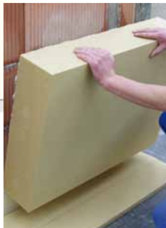
▼ Colocación sobre muro de ladrillo
