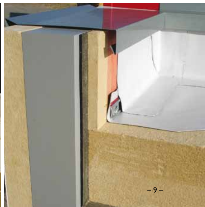
GUTEX Thermoflat sobre fondo de hormigón
